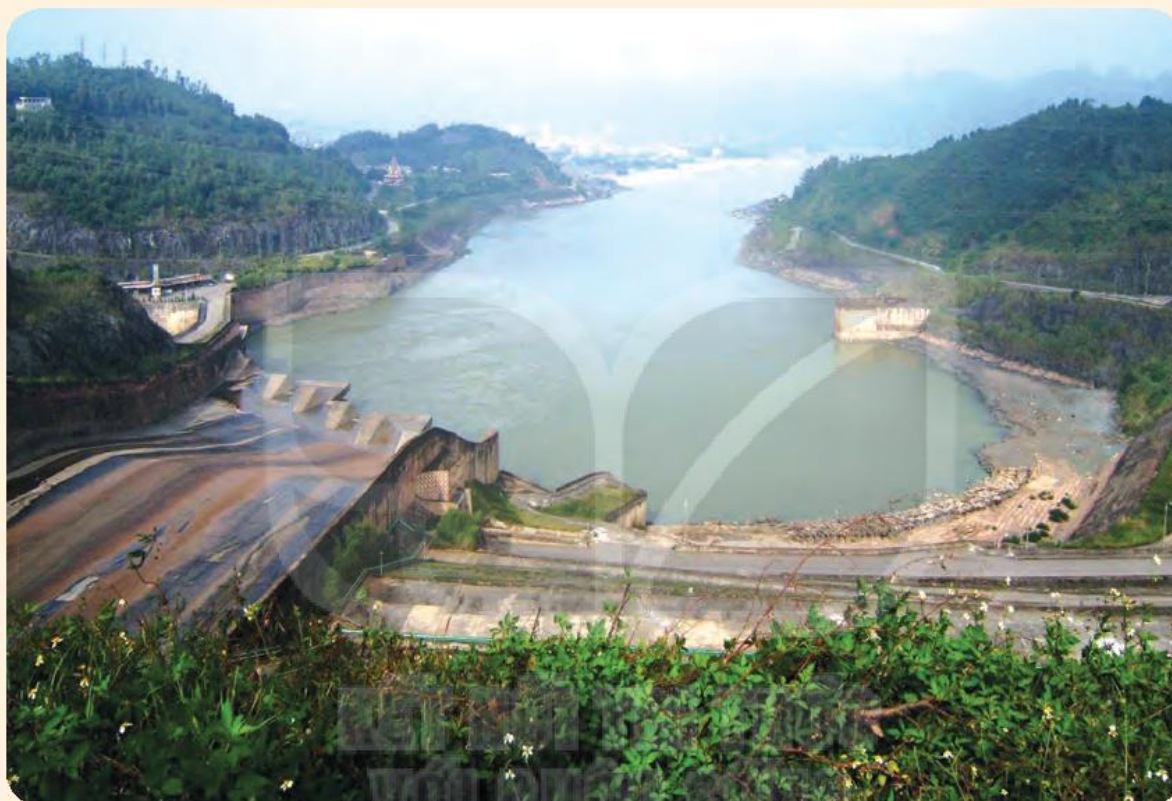
a) Đập thủy điện
