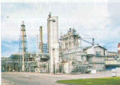
a) Xây dựng các nhà máy
