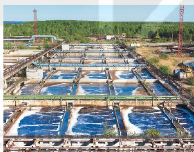
Hình 22.3. Các bể xử lý sinh học trong khu xử lý nước thải
