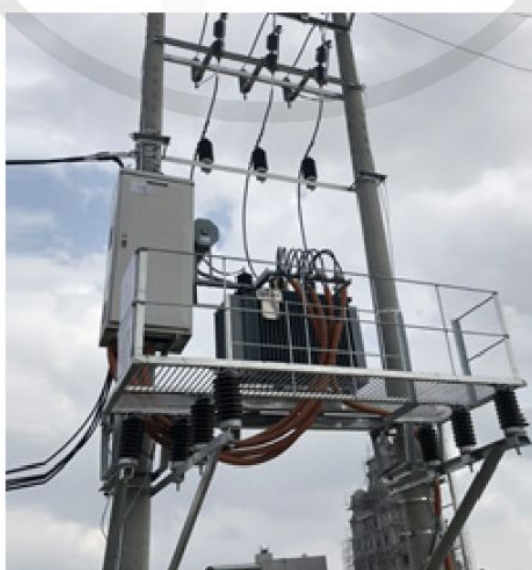
Hình 6.2. Trạm biến áp treo
