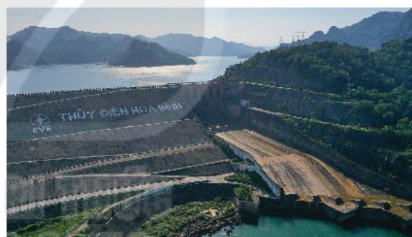
Công trình thủy lợi – thủy điện Hoà Bình (4)
