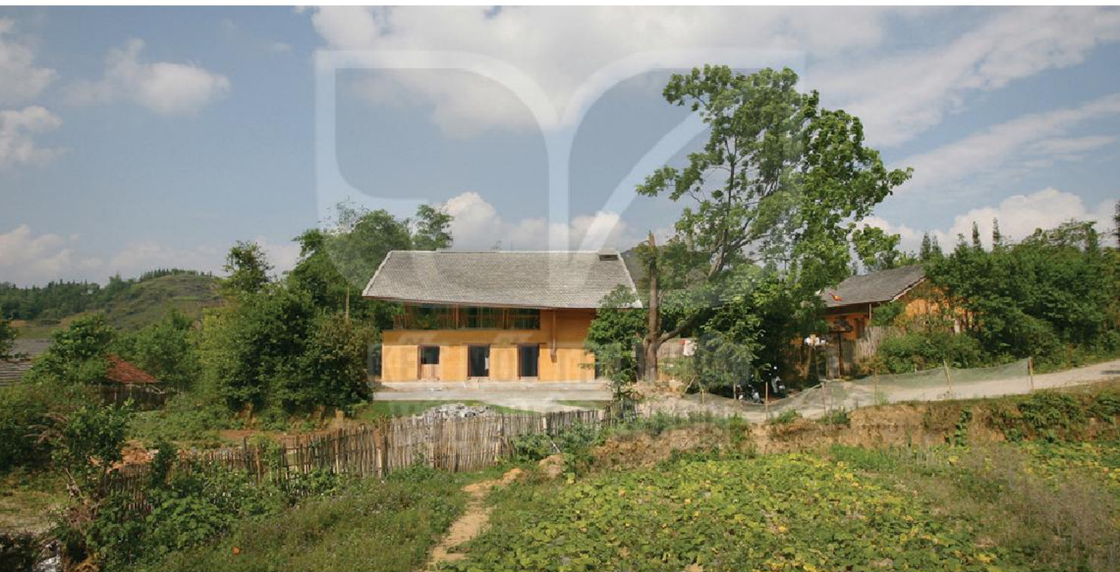
Công trình nhà cộng đồng và Homestay Nậm Đăm xây dựng trong thực tế (1)
