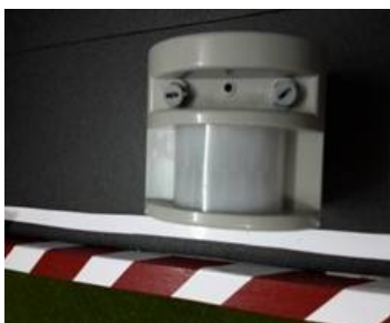
Lắp thiết bị phát tia hồng ngoại Thiết bị tự động phát hiện lỗi vượt đèn đỏ vào trụ đèn giao thông
