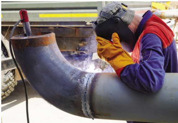
Hình 3.9. Hàn đường ống
