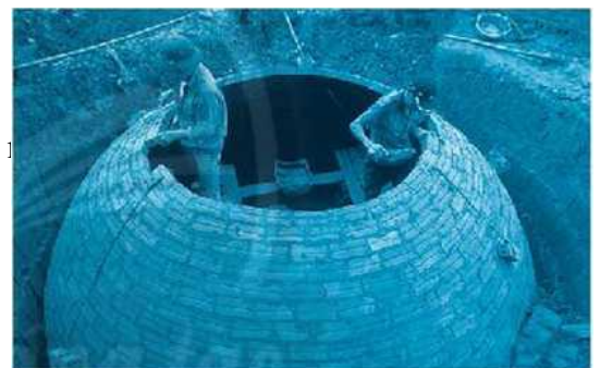
Xây hầm ủ chất thải gia súc để lấy biogas
