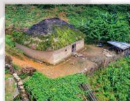
1. Nhà trình tường ở Lào Cai
