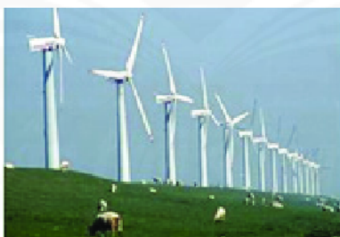
Điện gió Bình Thuận.
