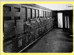
Hình 3. Máy tính ENIAC (Giôn Mau-li và Prét-pơ Êc-cơ, 1946) – máy tính điện tử đầu tiên
