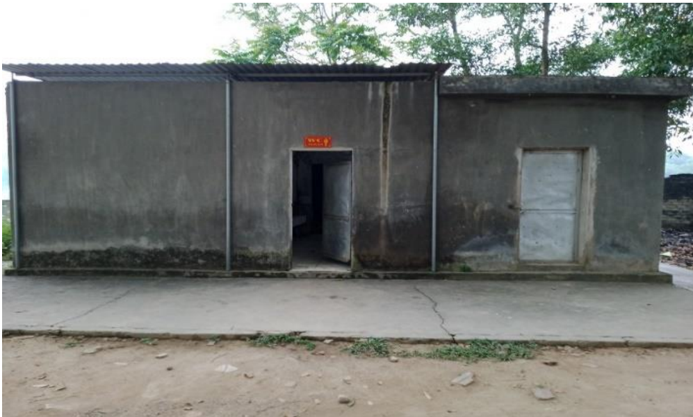
Nhà vệ sinh học sinh
