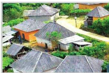
② Nhà trình tường – Nguồn: Thanh Thanh
