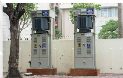
▲ Hình 2.7. Trạm biến áp đặt trên vỉa hè
