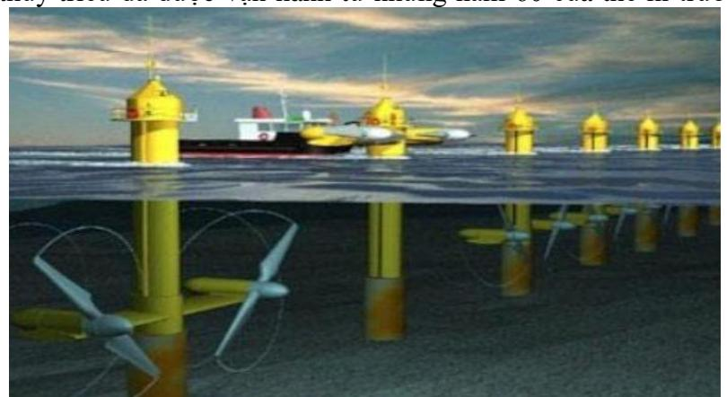
Một máy phát điện thủy triều khi hoạt động, nếu trong mỗi giây có  $9,7 \times 10^5$  kg nước biển chảy vào mỗi tua bin với tốc độ 3,0 m/s và chảy ra với tốc độ 1,0 m/s thì tạo ra công suất điện đôi với mỗi tua bin là  $1,2 \times 10^6$  W. Coi công suất dòng nước cung cấp cho mỗi tuabin bằng hiệu số động năng của dòng nước chảy vào tuabin và chảy ra khỏi tuabin trong một giây.
