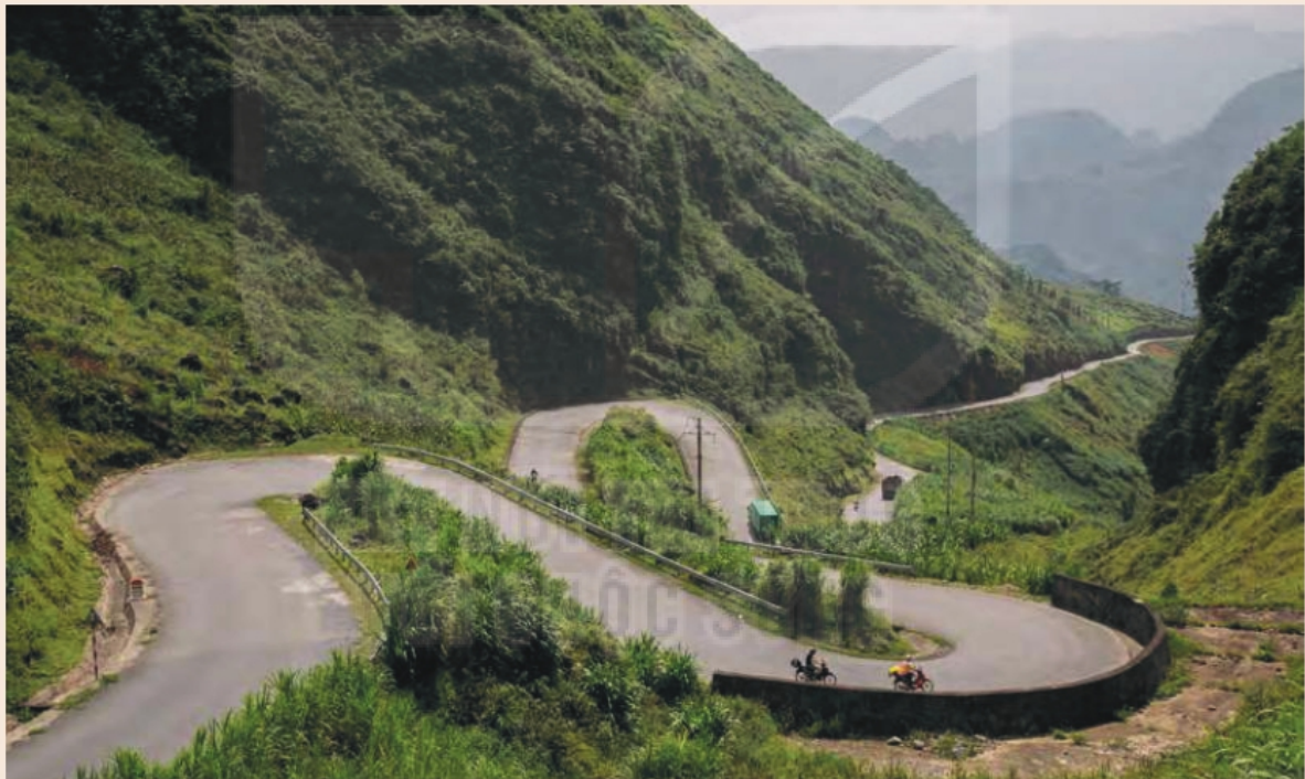
Hình 25.7. Đường đèo dốc dài, quanh co
