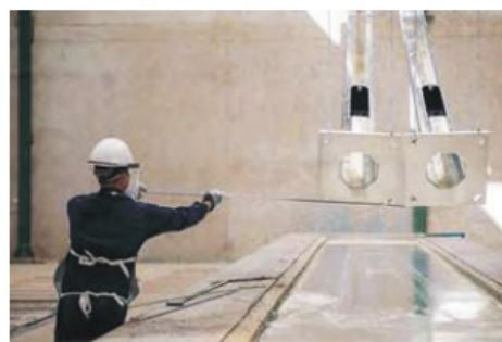
b) Xử lý bề mặt cột điện
