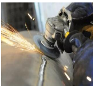
Hình 3: Môi hàn kim loại đang được mài nhẵn.
