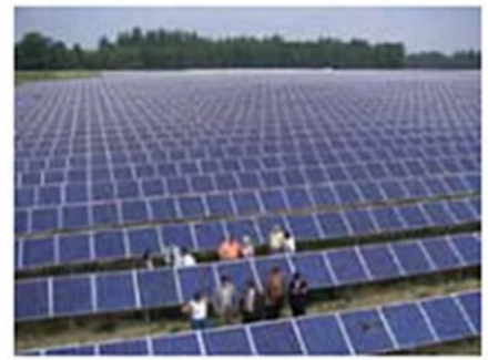
c) Nhà máy điện mặt trời
