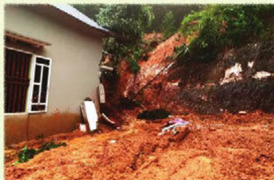
Hình 7. Sạt lở đất
