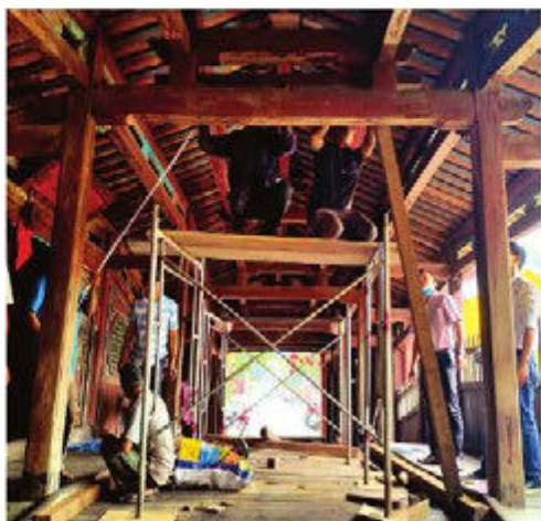
Hình 6. Chèn, chống cột bảo vệ di tích
