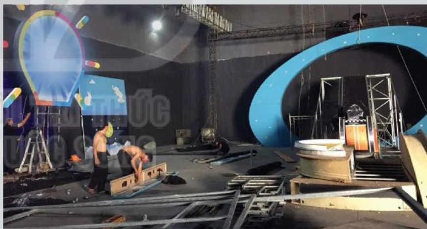
Lắp đặt sân khấu trường quay (1)
