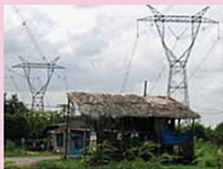
H19.10 Một căn nhà ở gần đường dây điện cao thế (ảnh chụp năm 2006)
