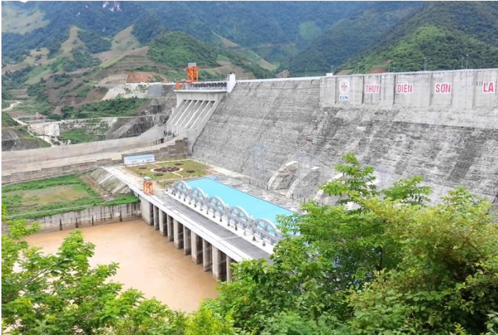
Nhà máy thủy điện Sơn La
