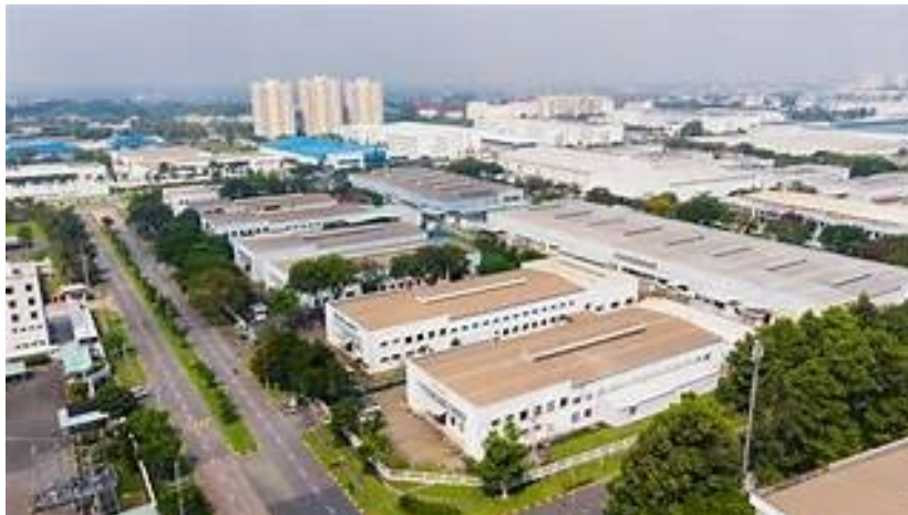
Khu công nghiệp Vsip Hải Phòng
