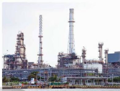
▲ Nhà máy lọc dầu
