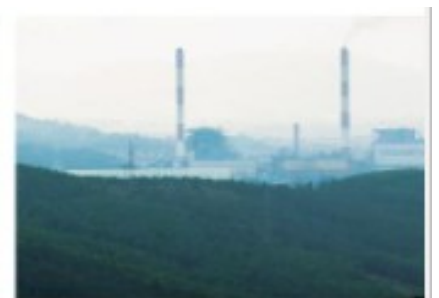
▲ Hình 10.8. Nhà máy nhiệt điện
